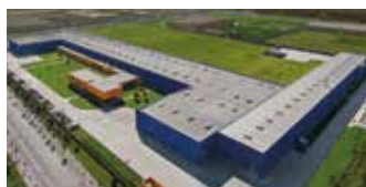
Hörmann Tianjin, Chine
