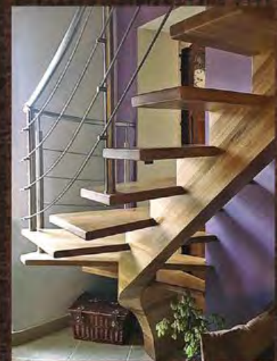
1/4 tournant centre débillardé avec garde corps lisses inox cintrées LR40.
